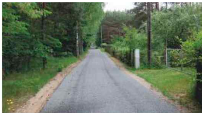
Droga w Białej Wielkiej po scaleniu
