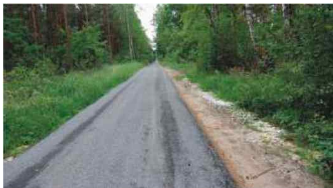
Droga 2 w Białej Wielkiej po scaleniu
