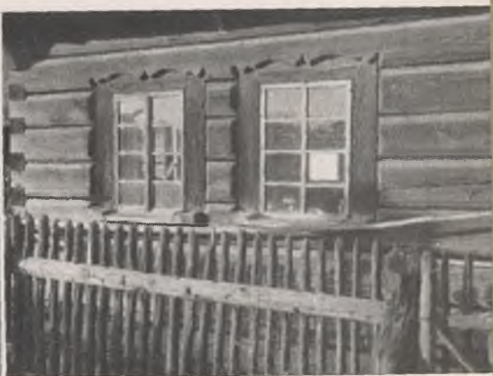
Blockhaus bei Glemien
