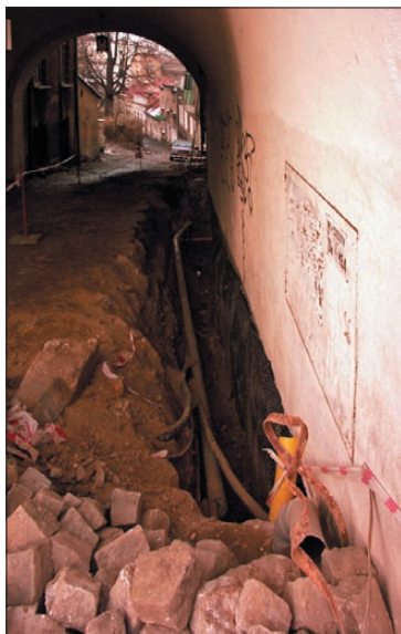
Osuszanie murów Książnicy Cieszyńskiej.
