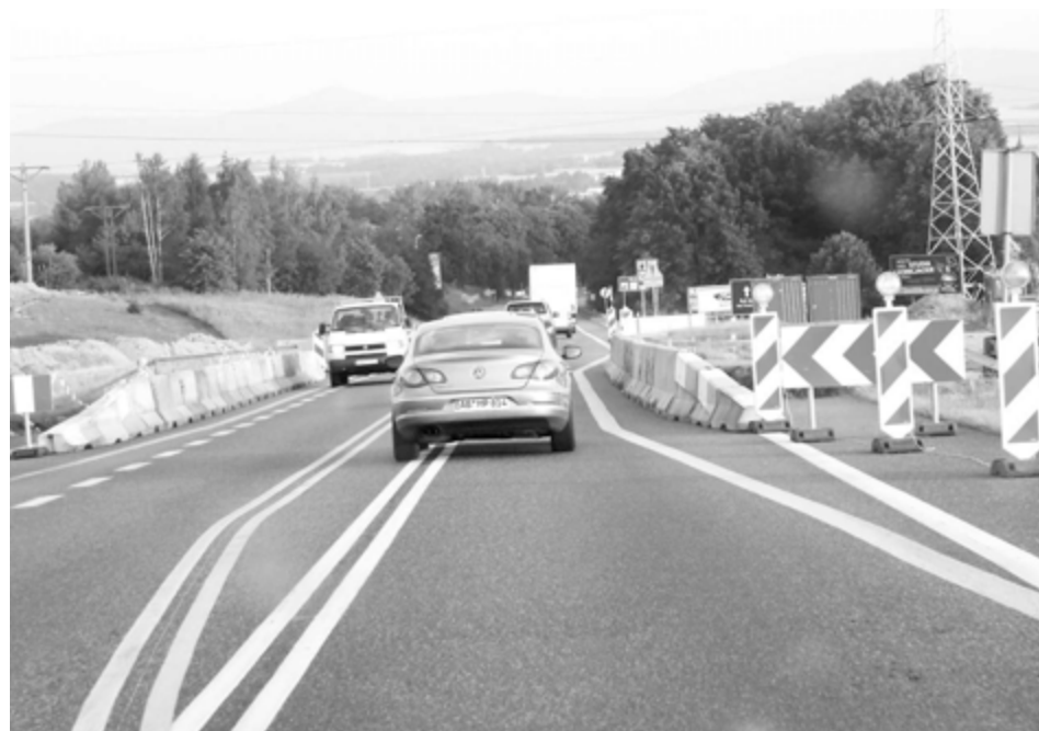
Zwężenie drogi, betonowe bariery i noc mogą stanowić śmiertelną mieszankę
