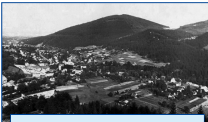
Początek lat 70-tych - Dom Turysty stoi już od kilku lat (w dolnym lewym rogu fotografii), natomiast dopiero budowany jest Włókniarz (nieco wyżej na zdjęciu).
