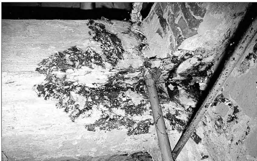
Powyżej: Przyczyną wielu poważnych zniszczeń we wnętrzu willi, szczególnie w piwnicy, okazał się grzyb (1995/1996). Fotografia ta pochodzi z dokumentacji konserwatorskiej willi.
