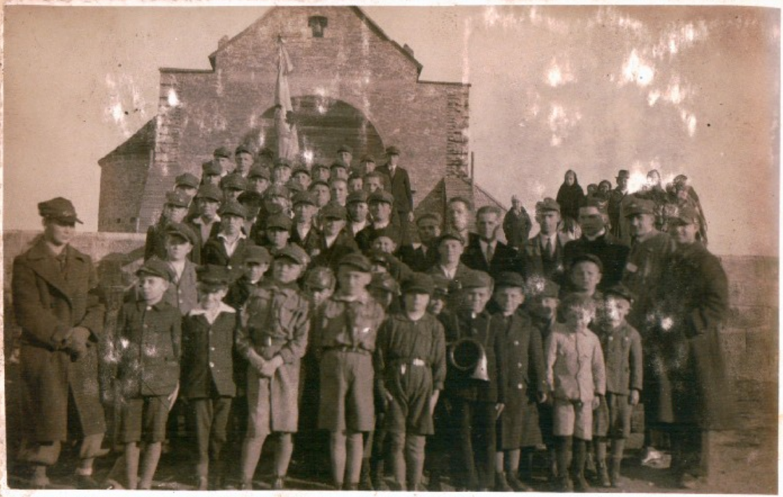
Spotkanie męskiego KSM-u przed kościołem w trakcie budowy, około 1935-36 r.
