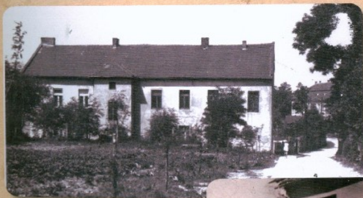
Stary budynek szkoły.
