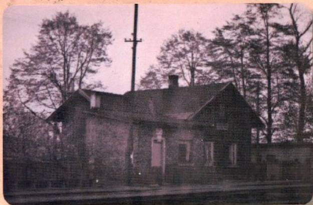
Budynek stacji kolejowej Byczynie.
