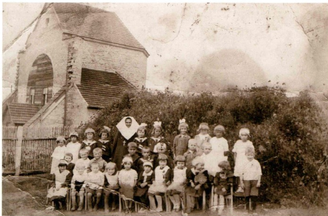
Obok kościoła w trakcie budowy, zdjęcie około 1935 roku.
