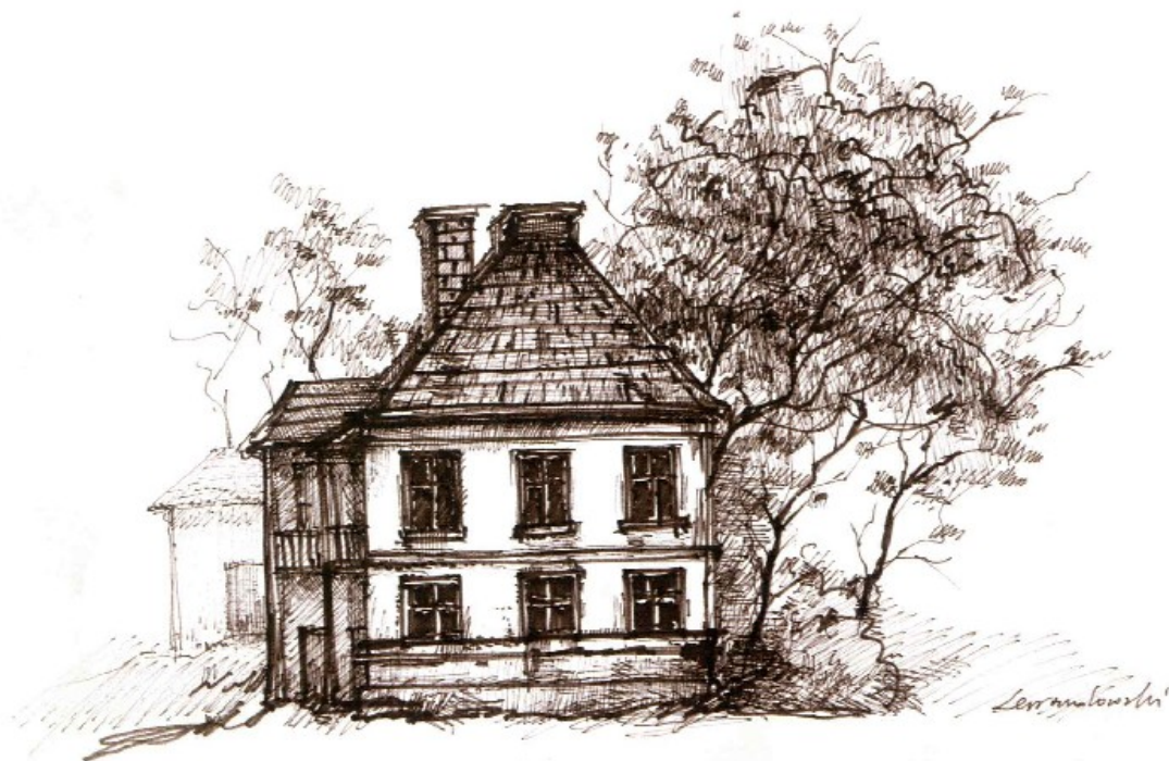
Pierwszy budynek szkolny w Byszynie w latach 1840-1905, rysował Leszek Lewandowski.
