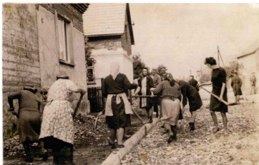
Budowa dróg w czynie społecznym.
