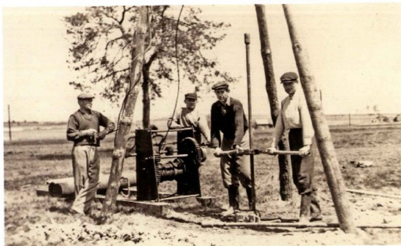
Wiercenie studni na potrzeby hodowli bydła rok 1950-1953 (pracownicy ZBM Kraków).
