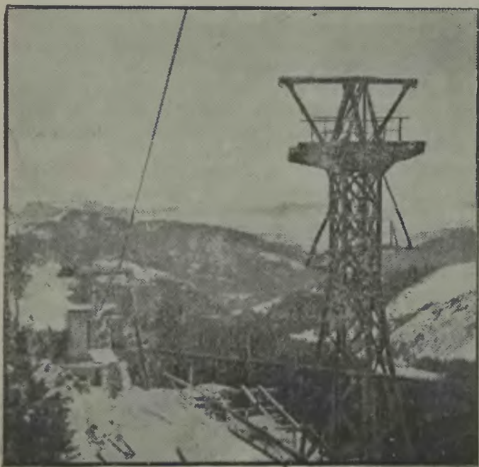
Wieża podporowa kolejki linowej na Kasprowy.
