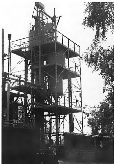
Instalacja doświadczalna pirolizy fluidalnej węgla
