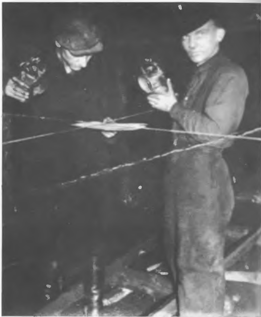
Stefan Pałucha i Marian Ledwójcik przy wytyczaniu kierunku osi chodnika "Pole Ia Małobądz" pokład "Szczęsny" grubość około 2 m. - 160 m. pod ziemię
