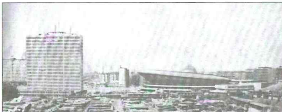
Na miejscu starego dworca kopalnianego KWK „Katowice” powstaje nowe centrum miasta.
