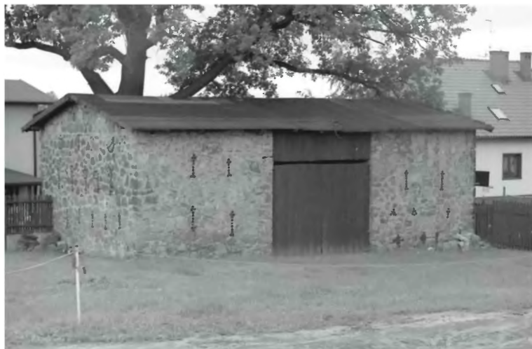
Przykład zabudowy gospodarczej z kamienia z przełomu XIX i XX w. Stodoła z łamanego piaskowca, u zbiegu ul. Czeresniowej z ul. Wiązową, na terenie gospodarstwa Siewiorów. Widok od strony skrzyżowania obu ulic. Nowe Tereny Kamionki. Fot. AAJ (2005)
