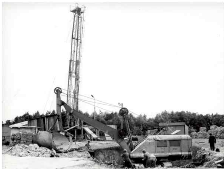
Początki głębenia szybu Bujaków 2 - 1986 rok
