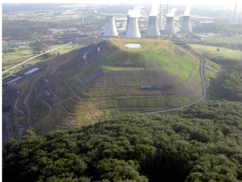
Składowisko odpadów pogórnictwa „Skalny”. Widok z lotu ptaka.
