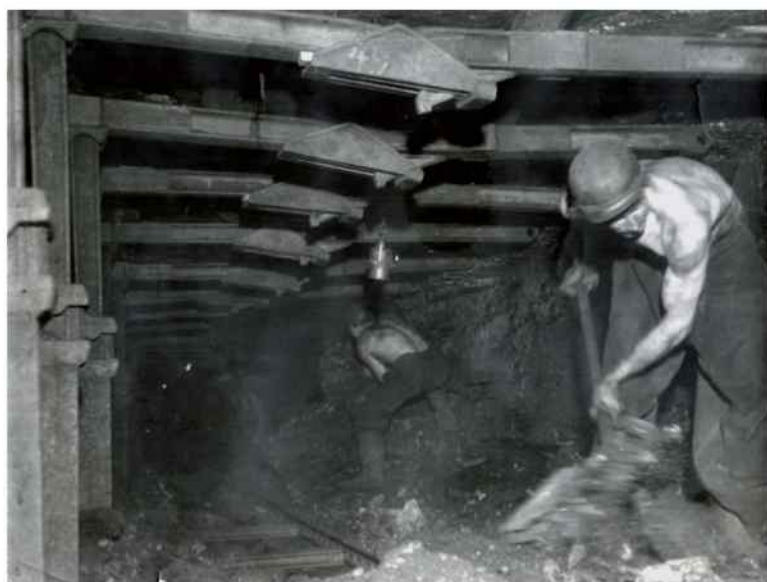
Ściana wydobywcza z obudową stalowo-członową w kopalni „Bolesław Śmiały”. Lata sześćdziesiąte XX wieku.
