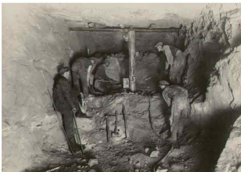
Kopalnia „Waleska” w roku 1935. Drażenie przekopu na poziomie 231 m, łączącego szyb Małgorzata z szybem Stary Zakład .
