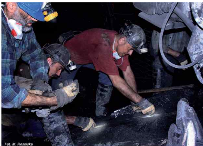
Chodnik 420a w pokładzie 324/3 - roboty montażowe
