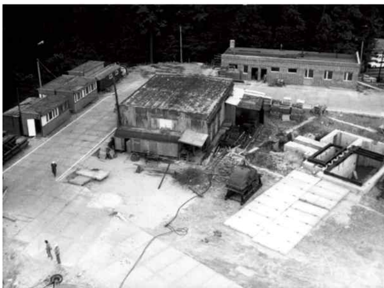
Budowa stacji wentylatorów głównych przy szybie Bujaków 2 – 1986 rok
