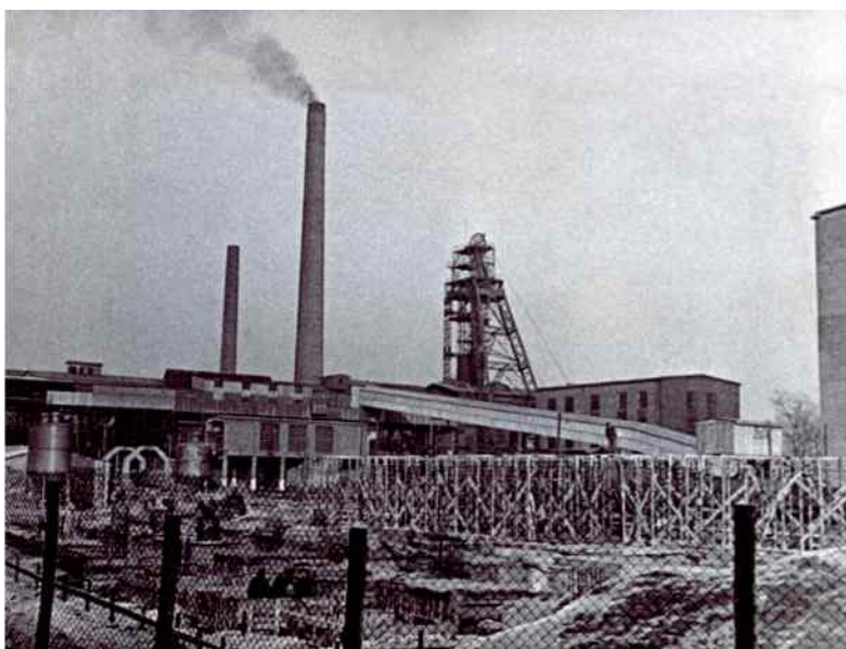
Budowa Zakładu Mechanicznej Przeróbki Węgla. Początek lat sześćdziesiątych XX wieku.
