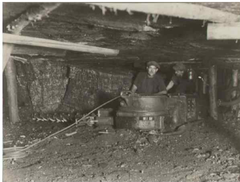
Żerdziowa wrębówka ścianowa o napędzie pneumatycznym w ścianie wydobywczej pokładu Maks kopalni „Waleska” w roku 1935.
