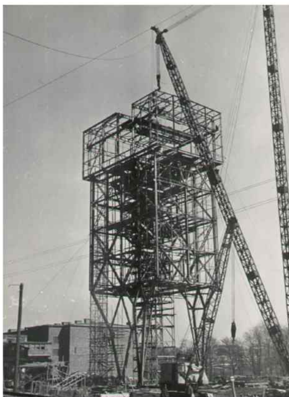
Montaż wieży szybowej szybu Aleksander III – marzec 1963 roku.
