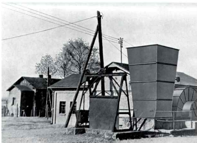
Szyb wentylacyjny Stary Zakład kopalni „Waleska”. Lata trzydzieste XX wieku.
