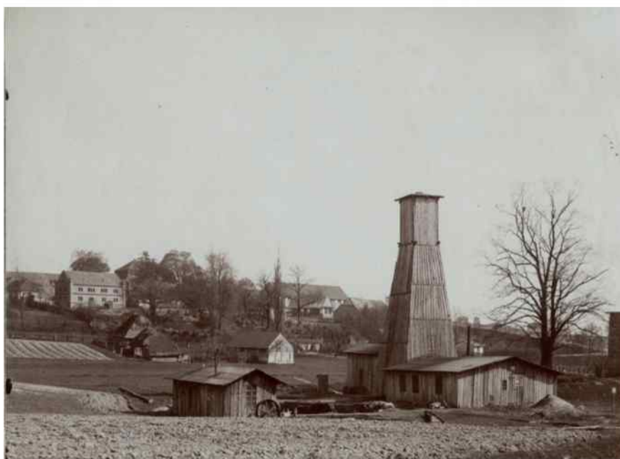
Wieża wiertnicza dla wiercenia głębokiego otworu badawczego (500 m). Łaziska Średnie rok 1900.
