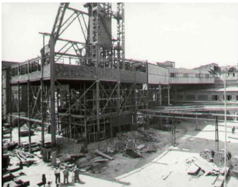
Modernizacja szybu Aleksander I w latach 1983-1984
