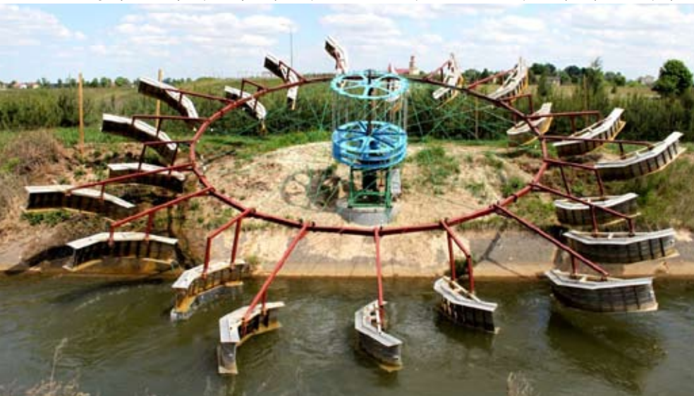
Elektrownia wodna na rzece Krasowa
