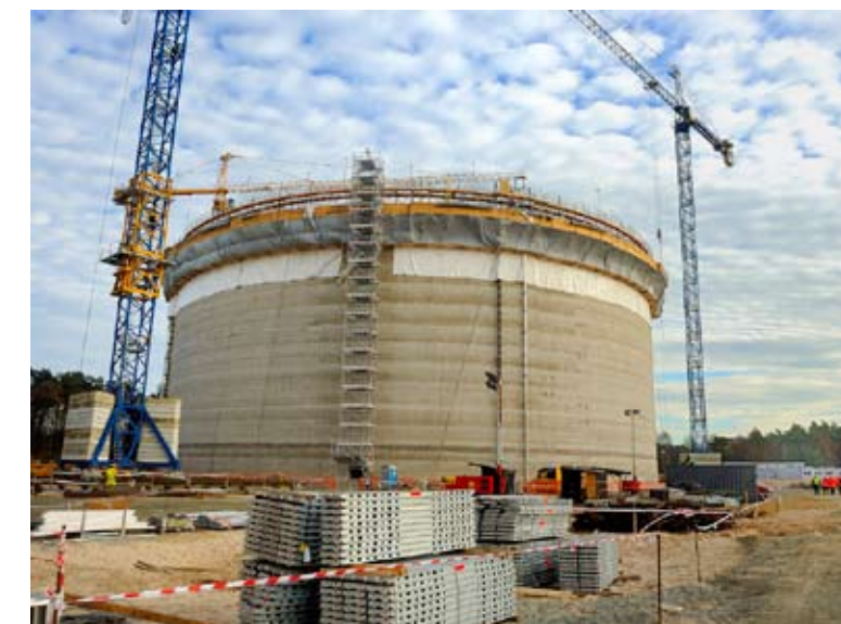
Terminal LNG w Świnoujściu w budowie
