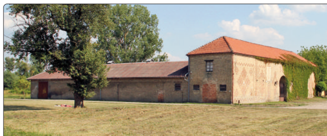
Zabudowania fabryczne w Choroszczy
