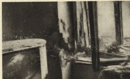
Jedno z mieszkań w domach kolejowych na Gródku, zdemolowane przez granat w czasie wybuchu amunicji.
