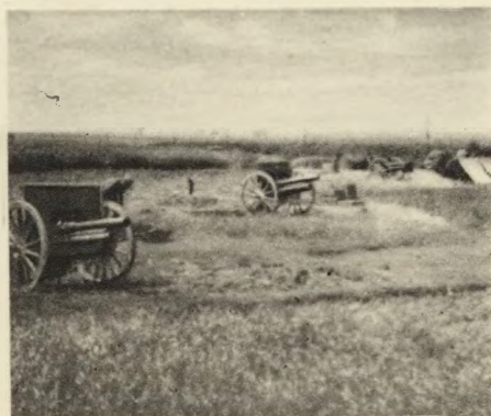
Stanowisko baterji. Une batterie en place. Battery in position.
