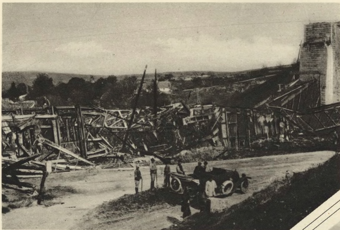
Zniszczony wiadukt w Płuchowie. Destruction d'un viaduc à Płuchów. The viaduct of Płuchów destroyed.
