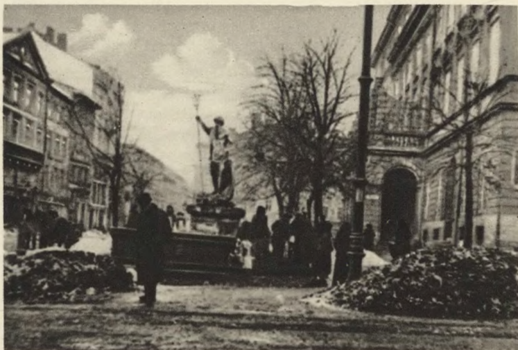
Po wodę. (Po zniszczeniu wodociągów).
