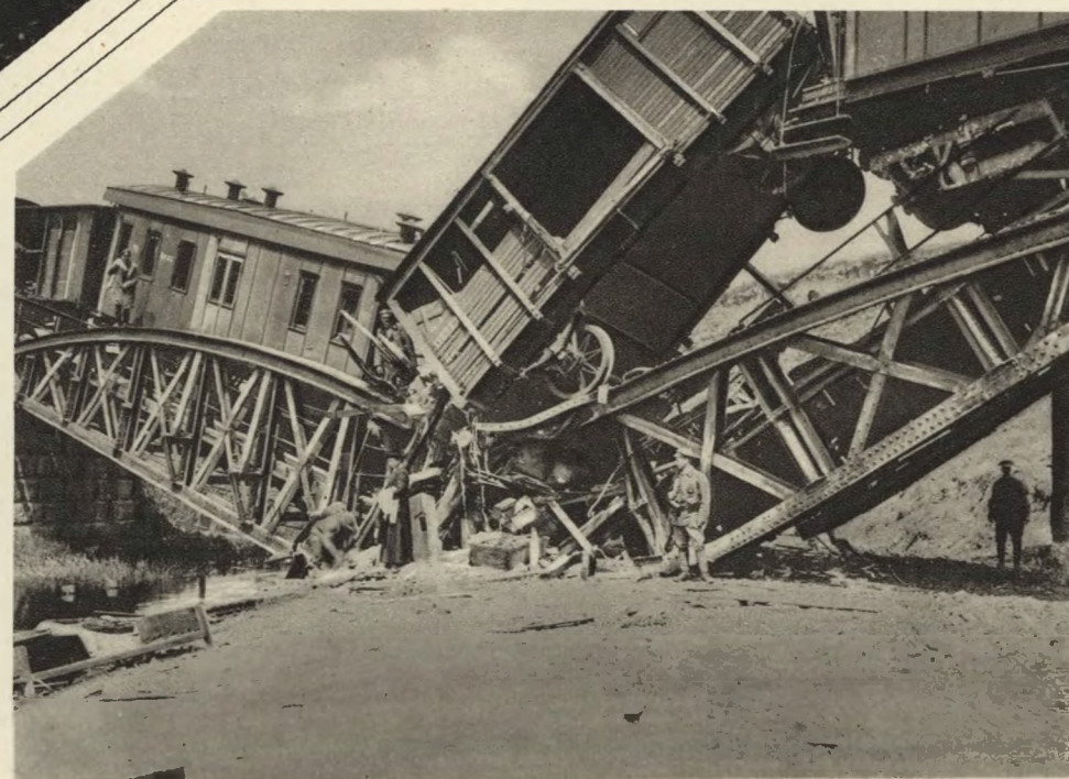
Most na Białej. Le pont sur la Biała. The bridge on the river Biała.
