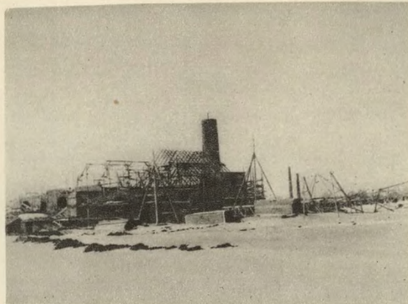
Betoniarnia z okopami. La fabrique de béton avec les tranchées. Factory of concrete with trenches.
