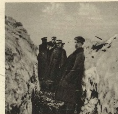
Okopy polskie pod Lwowem w trakcie bu- dowy. Tranchées polonaises près de Lwów au cours de leur construction. Polish trenches near Lwów under con- struction.
