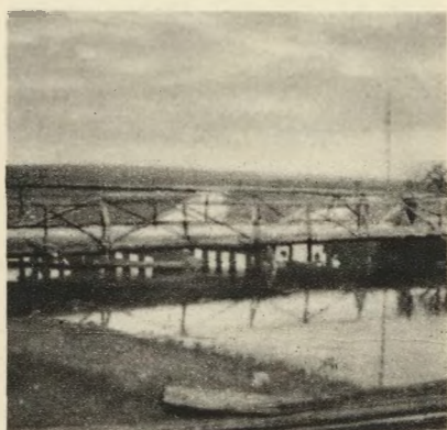
Most gotowy w przeciągu jednego dnia.
