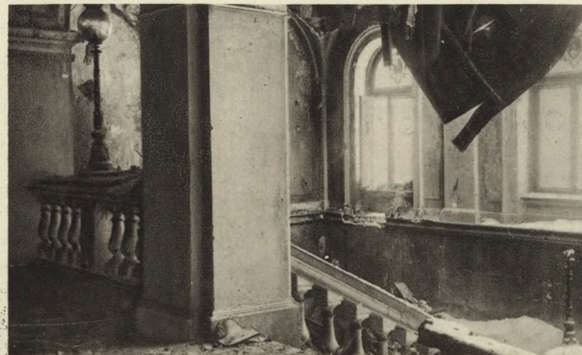
Spalona pocztą. Klatka schodowa.
