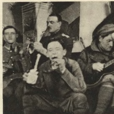
Grupa żołnierzy na placówce koło Beto- niarni. Groupe de soldats en position près de la fa- brique de béton. A group of soldiers at their post near the concrete factory.
