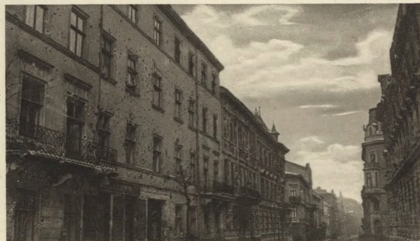
Górna część ulicy Sykstuskiej, domy uszkodzone pociskami.
