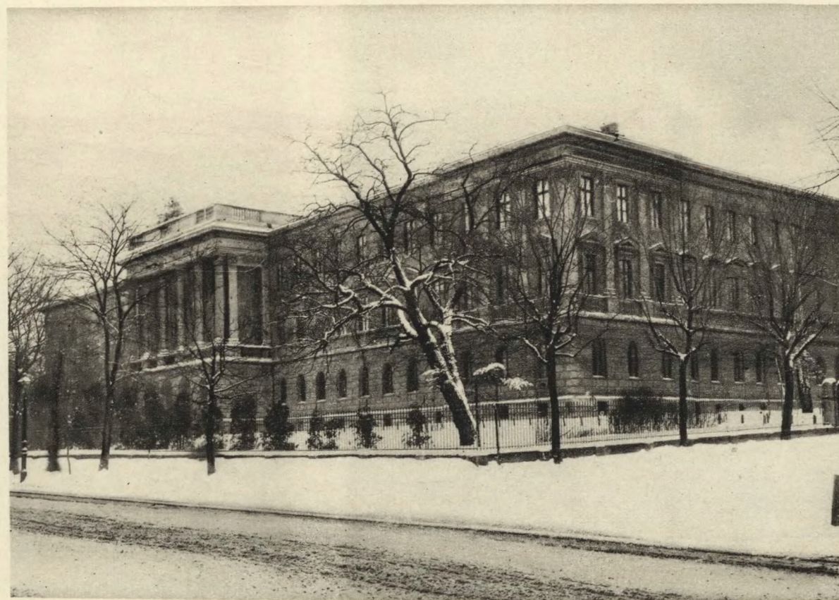
Polski szpital wojskowy Nr. I, umieszczony w budynku Politechniki Lwowskiej. L'hôpital militaire Nr. I. à l'École Polytechnique de Lwów. The Polish Military Hospital Nr. I. in the building of the Polytechnic School of Lwów.
