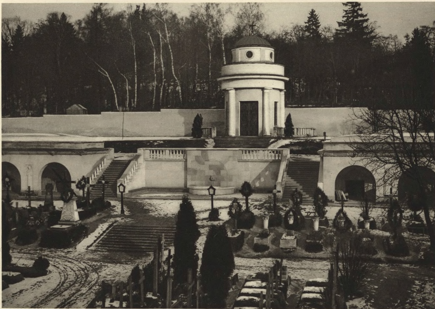
Vue de la chapelle.
