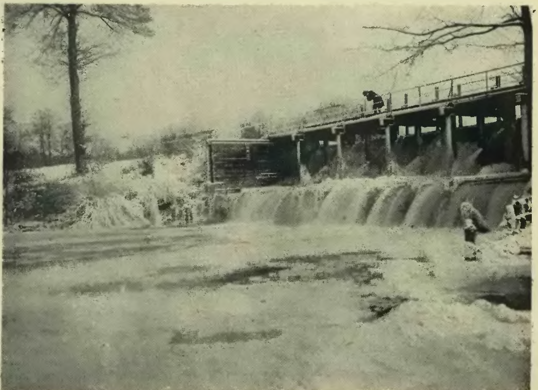
➡➡ Die Wasserkraft der Malapane diente Oberschlesiens alter Industrie der Grafen Colonna
