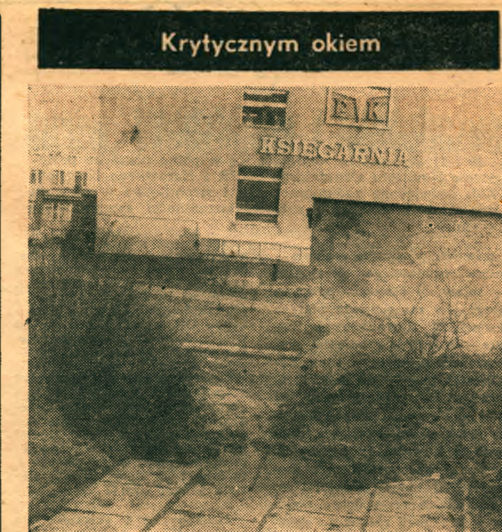
Chodnik biegnący wzdłuż budynku nr 55 urywa się gwałtownie. Tekst i zdjęcie: Z. Keller
