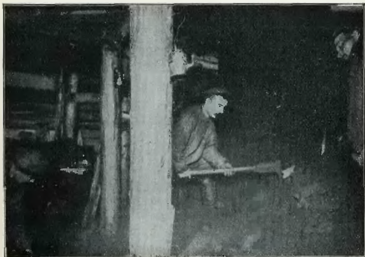
Gewinnung des Sandbernsteins aus der Blauen Erde durch Tiefbau. Bauer lösen die Schicht mit der Keilhaue, der Fördermann gibt das Gut in den Förderwagen
