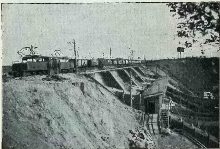
Bild aus dem heutigen Tagebaubetrieb zur Gewinnung des samländischen Landbernsteins. Die bernsteinhaltige Erde wird hier aus den Kippwagen, die sie von den Baggern erhalten, auf eiserne Roste geschüttet und zur sog. „Wäsche“ gebracht. Kräftige Druckwassersprahlen lösen sie zu einer „Trübe“ auf, die die Bernsteinstücke schwimmend mit sich führt, worauf das Ganze in Rinnen zum Abfluß gebracht und der Bernstein durch besondere Vorrichtungen zurückgehalten wird, während die Trübe selbst ins Meer fließt.
