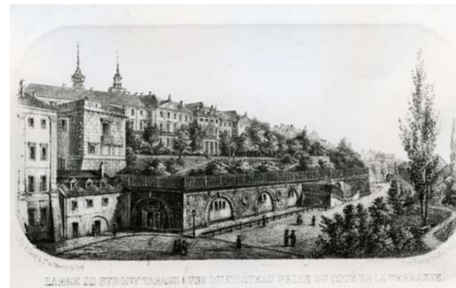
Widok Zamku od strony Wisły, Alfons Matuszkiewicz, 1859. Widoczny nowy ogród na skarpie i na Arkadach Kubickiego – przekształconych w stajnie kozackie.
