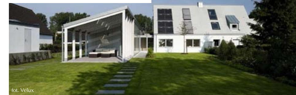
LichtAktiv Haus w Hamburgu po modernizacji
