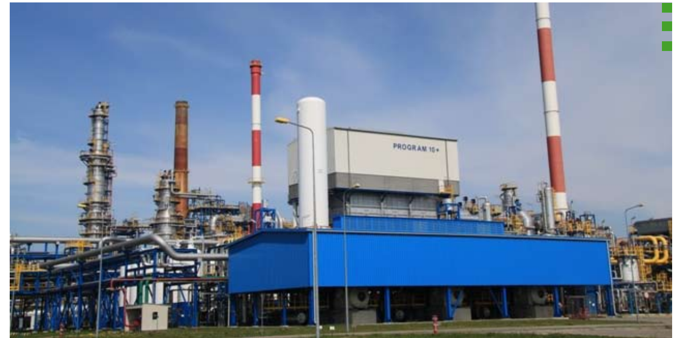
Nowa instalacja produkcji wodoru w GL
