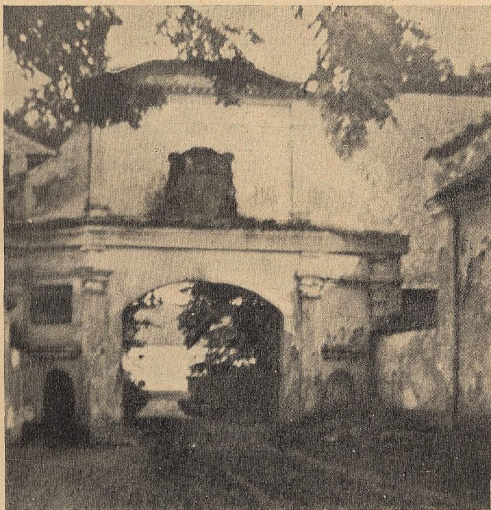
Abgerissenes Einfahrtor (Schloß Stolpanitz)
