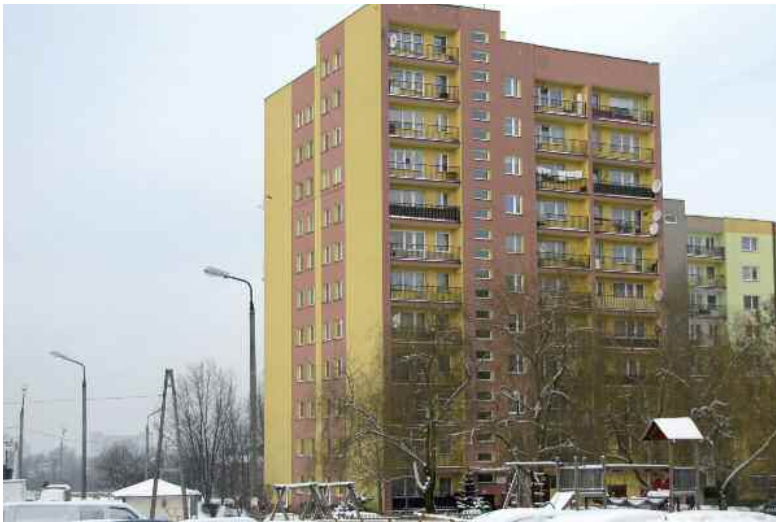
Zmodernizowany budynek należący do MZBM-u.
