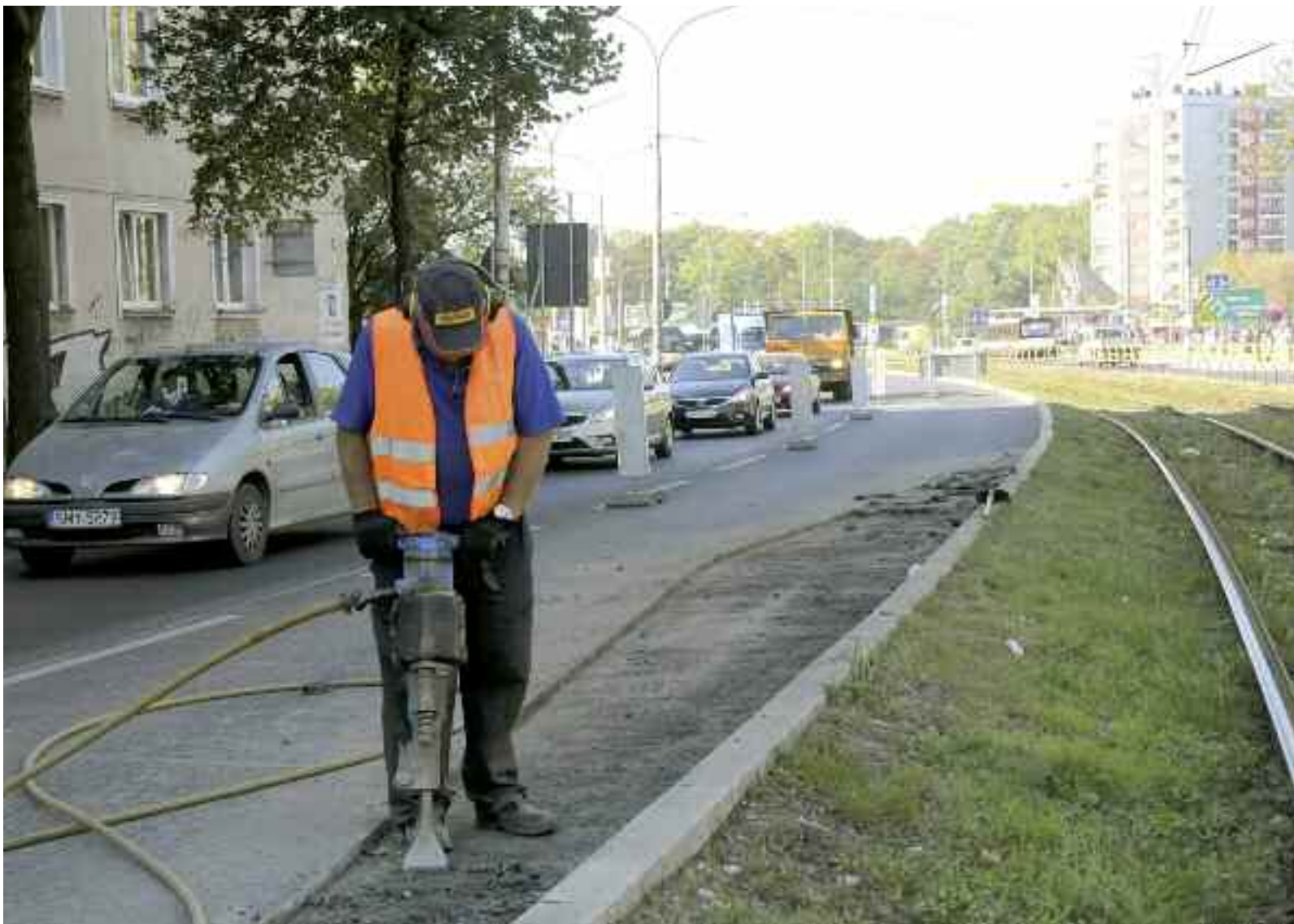
Prace przy skrzyżowaniu ulic Królowej Jadwigi i Augustynika.
