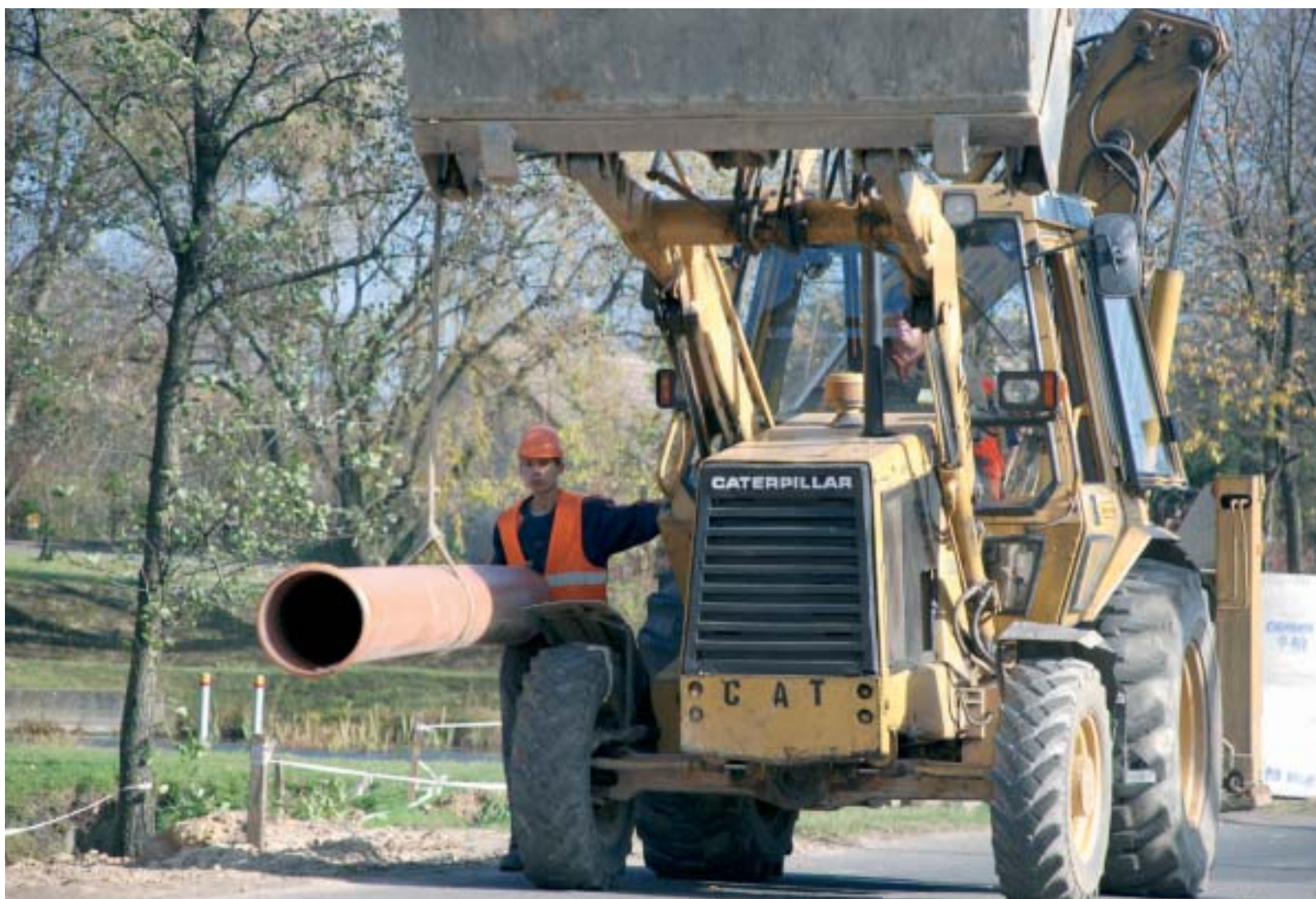
Już niebawem ruszą prace przy ulicach: Tworzeń, Majewskiego, Tysiąclecia, 11 Listopada i Leśnej.
