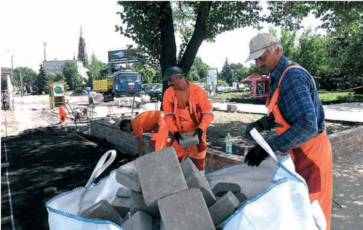
Na placu przed DH „Centrum” nowa nawierzchnia zastąpiła stare, popękane płyty chodnikowe.
