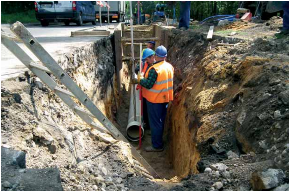
Prace związane z projektem trwają już w Gołonogu, Strzemieszycach i Tworzniu. Niebawem ruszą w kolejnych dzielnicach.
