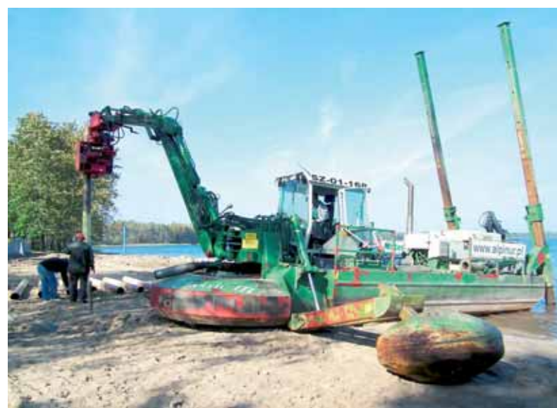
Specjalistyczna maszyna wbija pierwsze pale pod budowę mola spacerowego, które będzie służyło mieszkańcom już w przyszłym roku.
