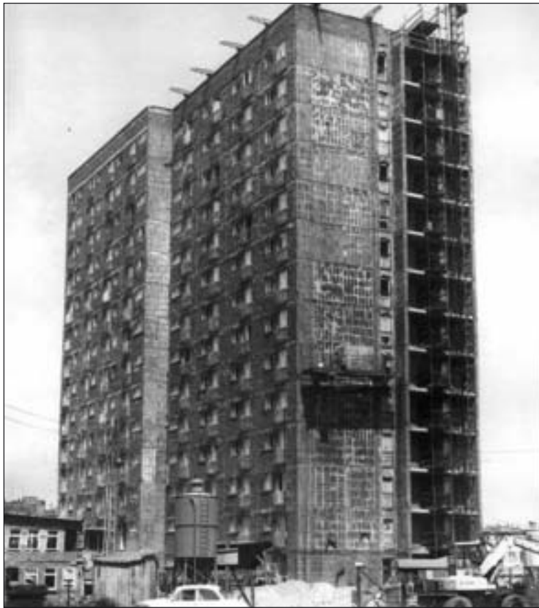
Budowa wieżowca przy ul. Adamieckiego 11 - do dzisiaj najwyższy budynek w mieście.
