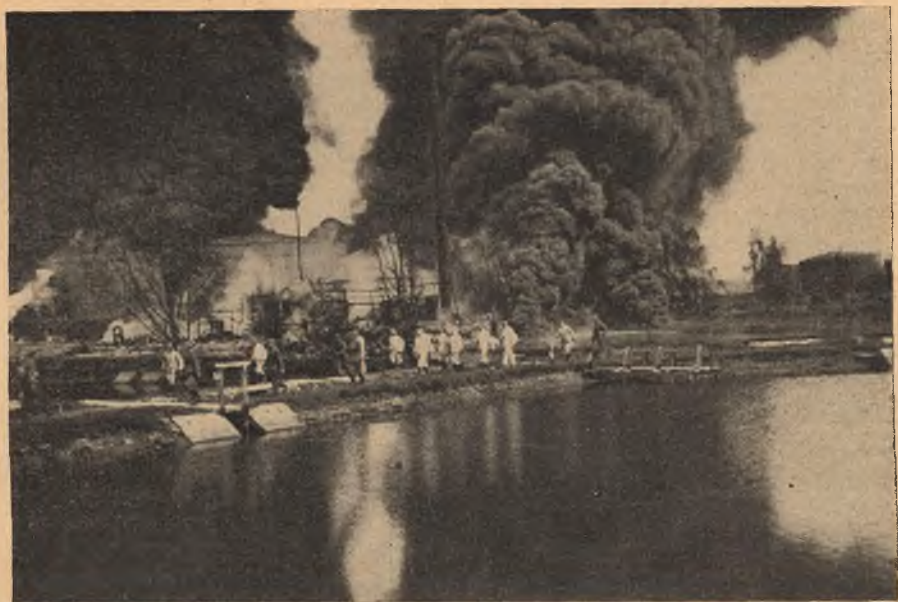
Löscharbeiten der Pioniere in den Werken in Drohobycz
