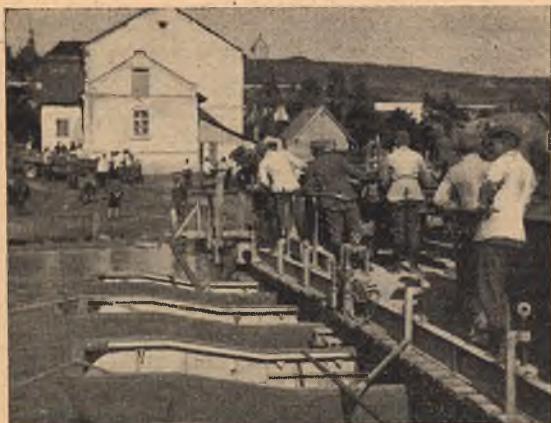
Errichtung einer Pontonbrücke
