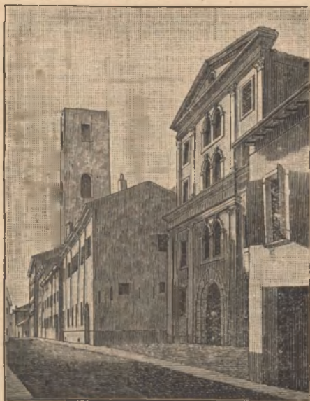
Dawniejsze kolegium Towarzystwa Jezusowego w Mantui, w którym św. Alojzy przebywał w Lipcu 1585, i w Październiku i Listopadzie 1589. Część kolegium przyległa kościołowi należała kiedyś do ojca św. Alojzego
