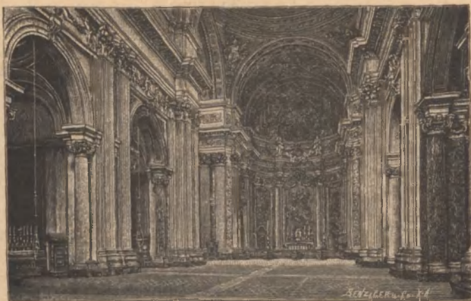
Wnętrze kościoła św. Ignacego w Rzymie, w którym znajduje się grób św. Alojzego.
