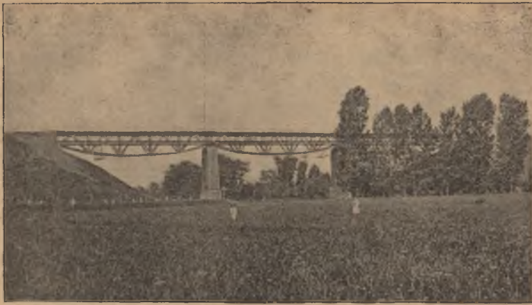
Eisenbahnbrücke bei Dieslau
