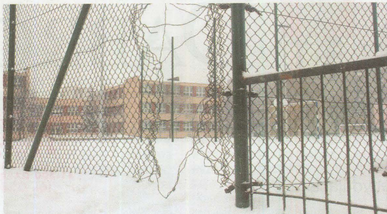
Zniszczone boisko - Orlik na osiedlu przy ul. Piłsudskiego. Takie widoki niestety nie należą do rzadkości.
