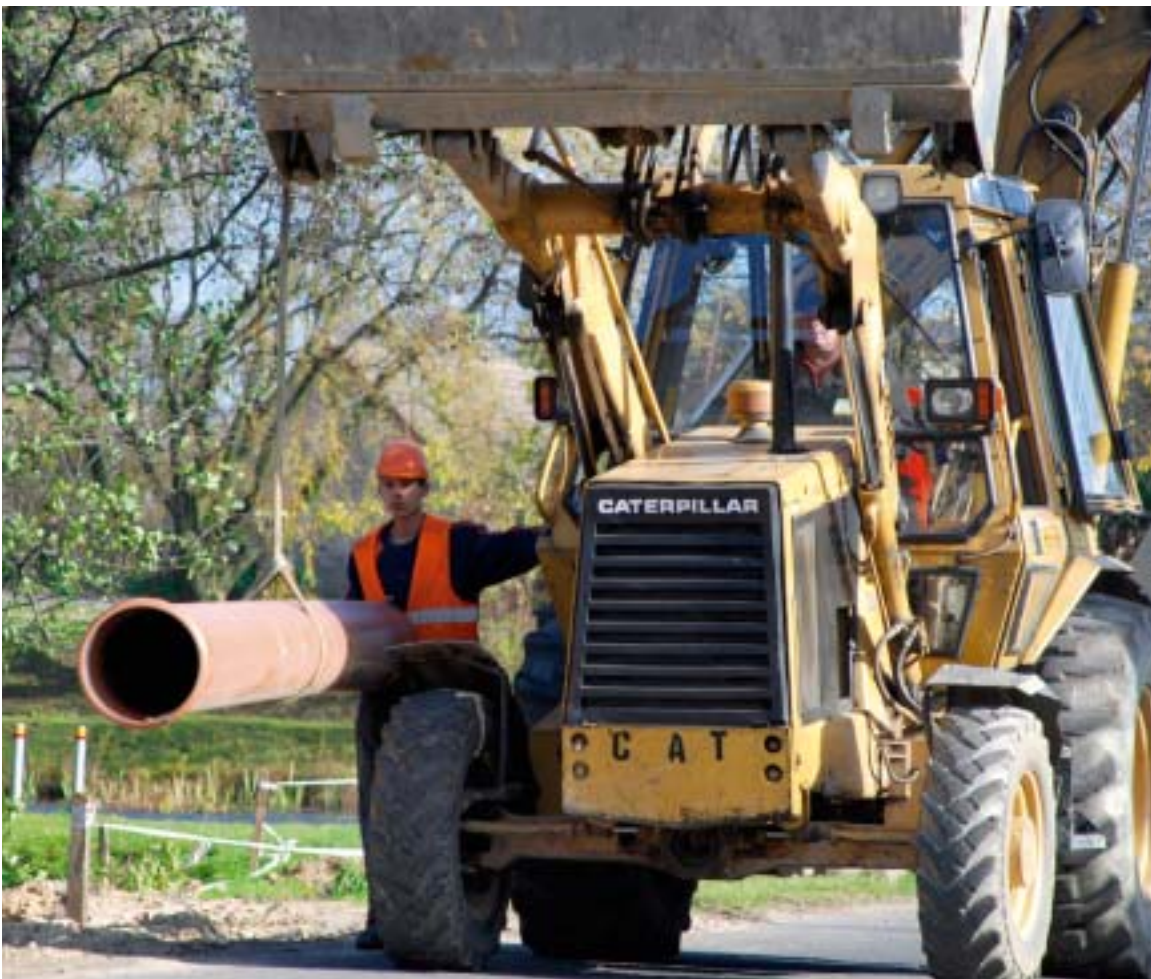
Pierwszy etap modernizacji starej i budowy nowej sieci kanalizacyjnej obejmie m.in. Strzemieszyce Wielkie.
