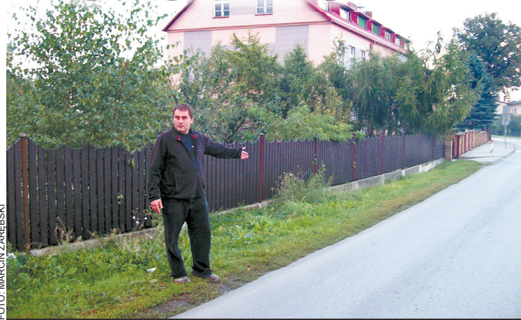
Paweł Prochot wskazuje miejsce, gdzie potrzebny jest chodnik.
