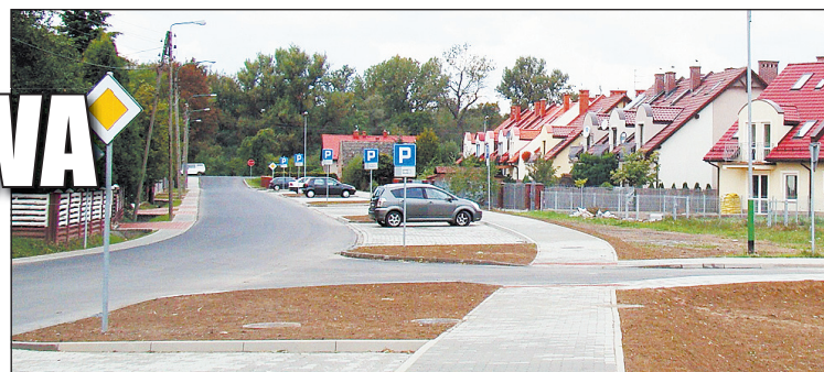
Ulica Zagrodowa w Oświęcimiu przeszła gruntowną modernizację.
