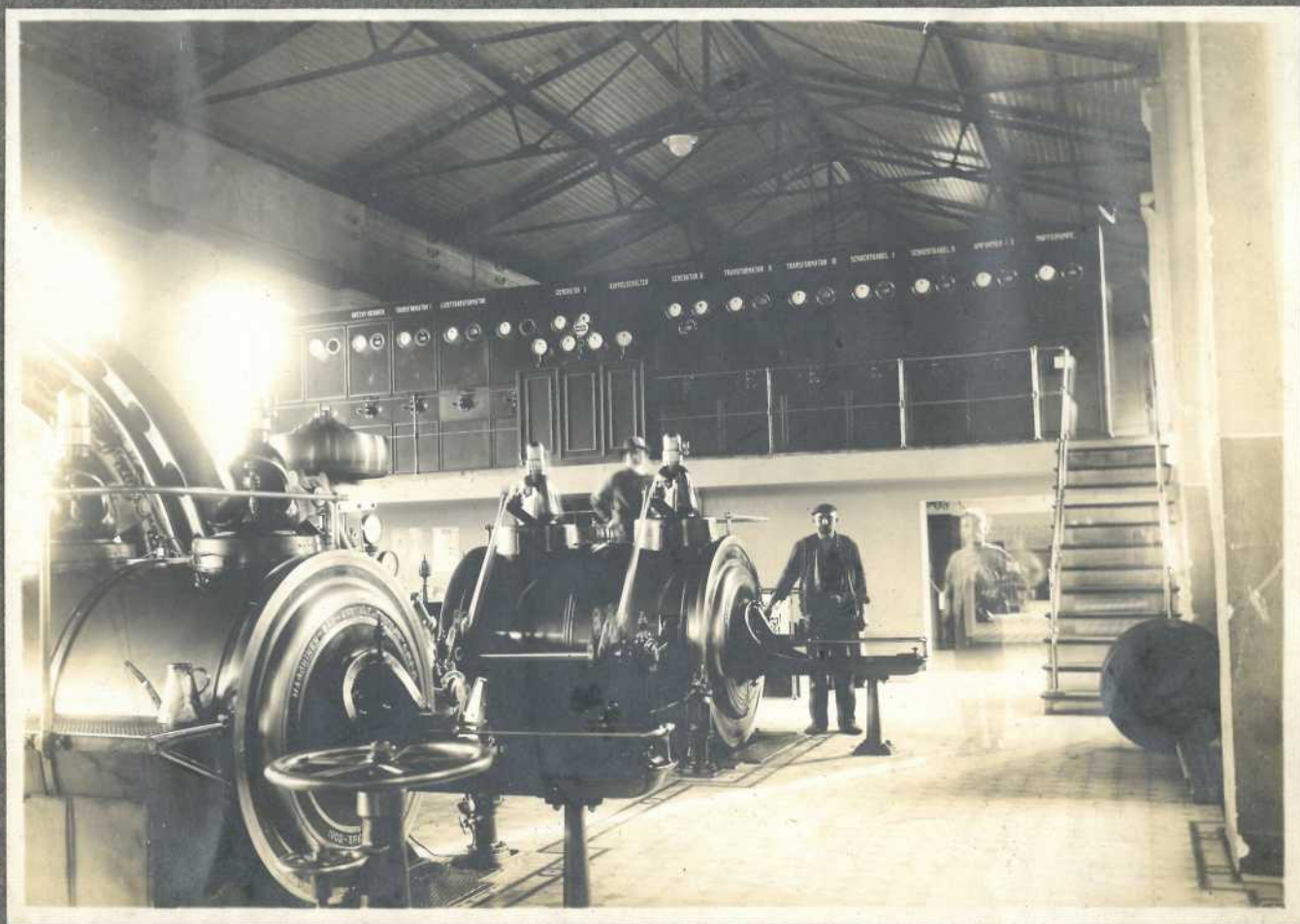
Neue Schalttafel der Trautscholdsegen-Ges.
