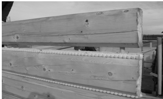
Rys. 3. Łączenie bali na kołki (dyble), (fot. autorki)
