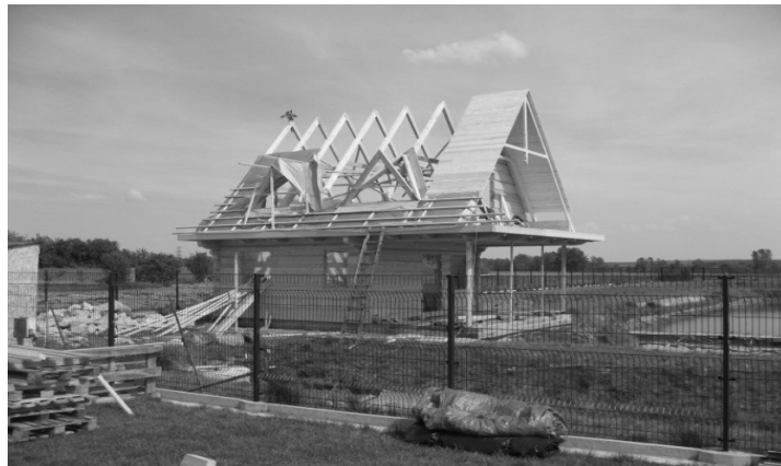
Rys. 5. Wieżba dachowa jętkowa (fot. autorki)
