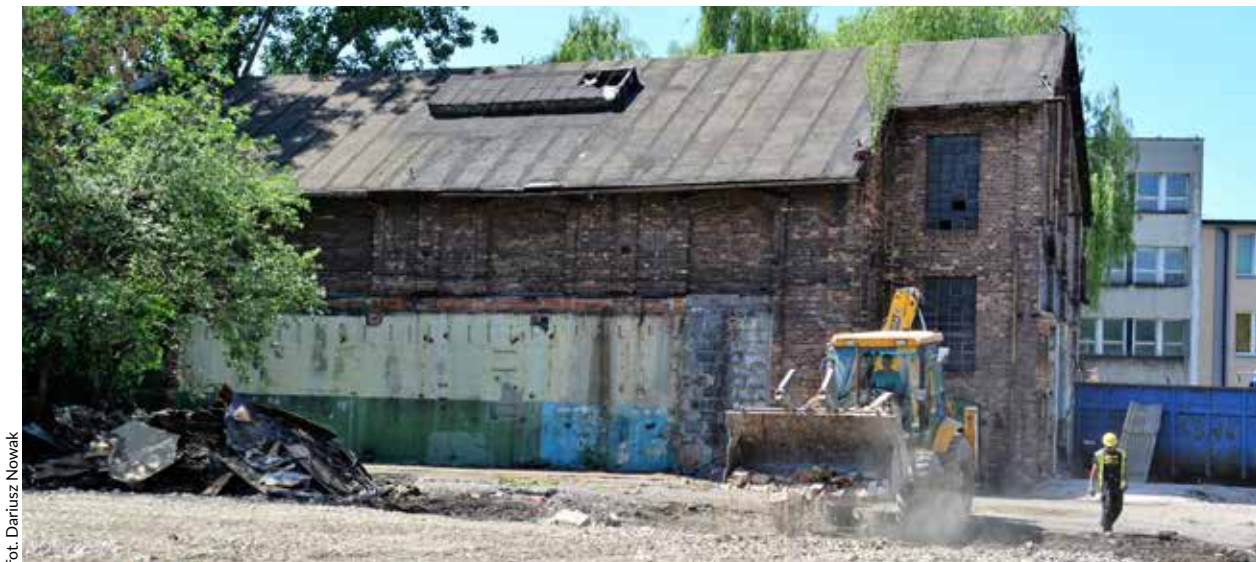
Prace porządkowe i zabezpieczające teren byłej fabryki DEFUM przed udostępnieniem go mieszkańcom i konsultacjami dotyczącymi jego zagospodarowania
