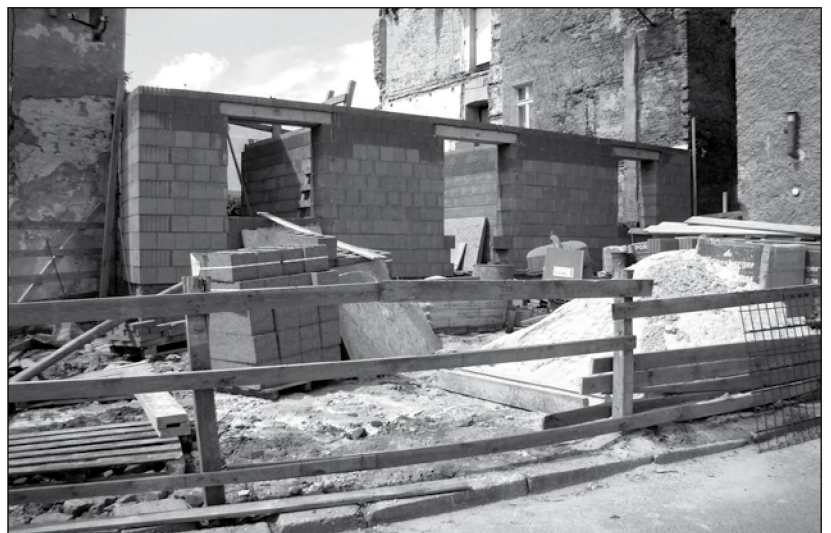
Budowa nowego domu od strony ul. Wałowej
