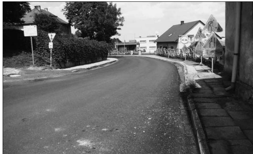
Fragment ul. Nyskiej (od strony ul. Opolskiej) po położeniu pierwszej warstwy bitumicznej.
