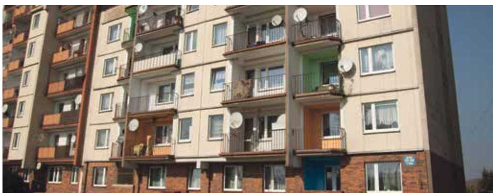
Został ogłoszony przetarg na docieplenie budynków przy ul. 3-go Maja 118-120 i 3-go Maja 122-126. Trwają prace dociepleniowe przy ul. Morcinka 2a.
