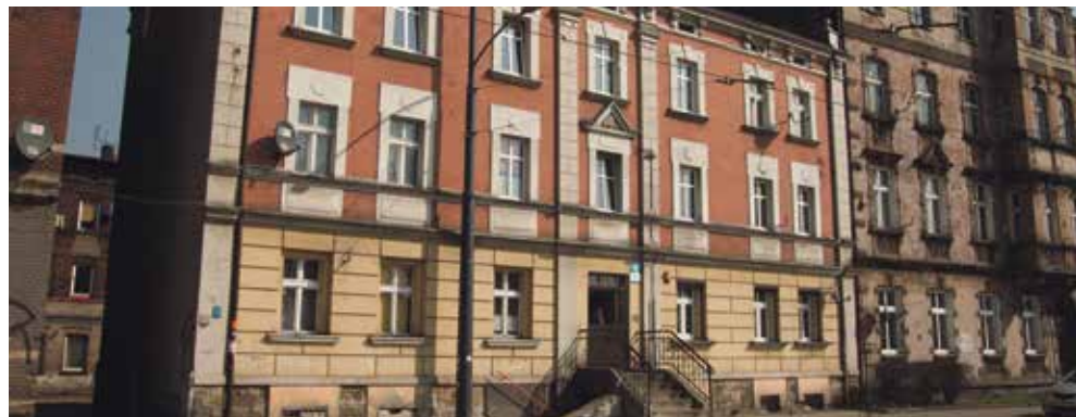
W trakcie rozstrzygnięcia jest procedura przetargowa na wykonanie remontów dachów przy: Brzezińskiej 9, 23-go Czerwca 4f, 4t, Truchana 38, 38a, 38b, Kościuszki 8, A. Krajowej 47, Farnej 28F.
