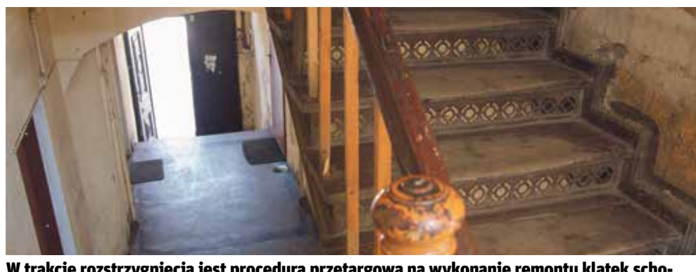
W trakcie rozstrzygnięcia jest procedura przetargowa na wykonanie remontu klatek schodowych przy: Pl. Piastowskim 1f, 1t, 3-go Maja 27, 27a, 27b, 3-go Maja 30, Mieleckiego 29, Mieleckiego 31, A. Krajowej 123, 123 a.
