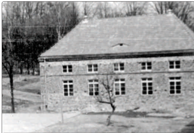
Rok 1957 - trwają prace wykończeniowe
