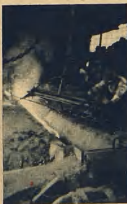
Młot pneumatyczny przebił otwór spustu i surówka popłynęła wrzącym strumieniem.
