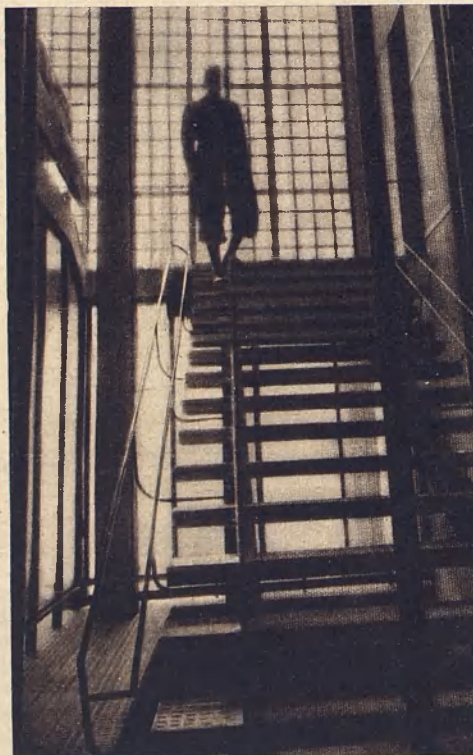
Schody ze szkła pokryte są tłoczoną gumą, a drzwi naprzeciwko nich składają się z metalowej siatki, wtopionej w szkło.
