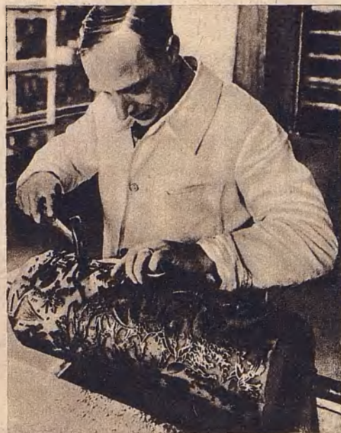
Przygotowywanie walca do druku tapety.
