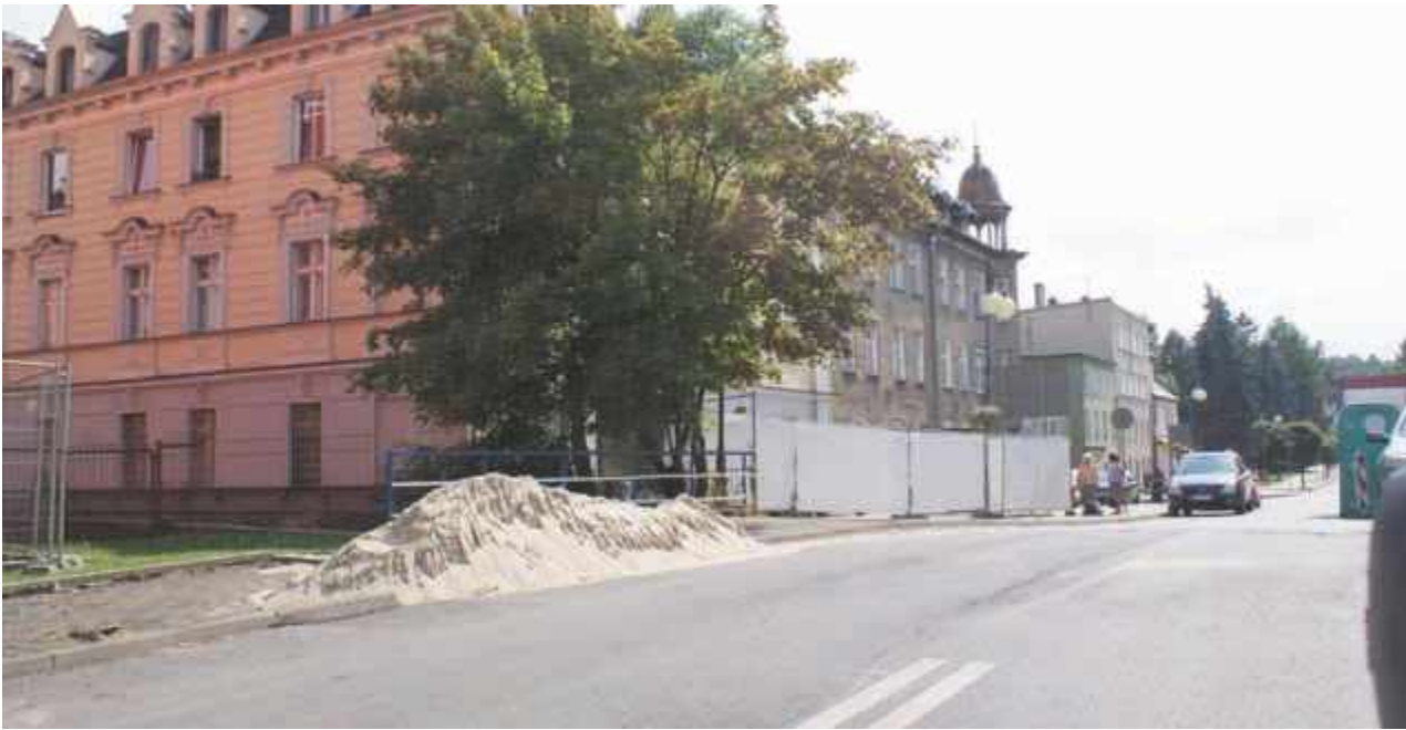
Remont potrwa około dwa miesiące
