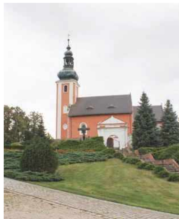
W kościele wymieniono poszycie dachu i odnowiono elewację
