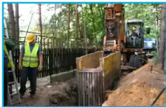
❧ POWIAT STRZELECKI: Budowa kanalizacji na ulicy Leśnej w Kolonowskim
