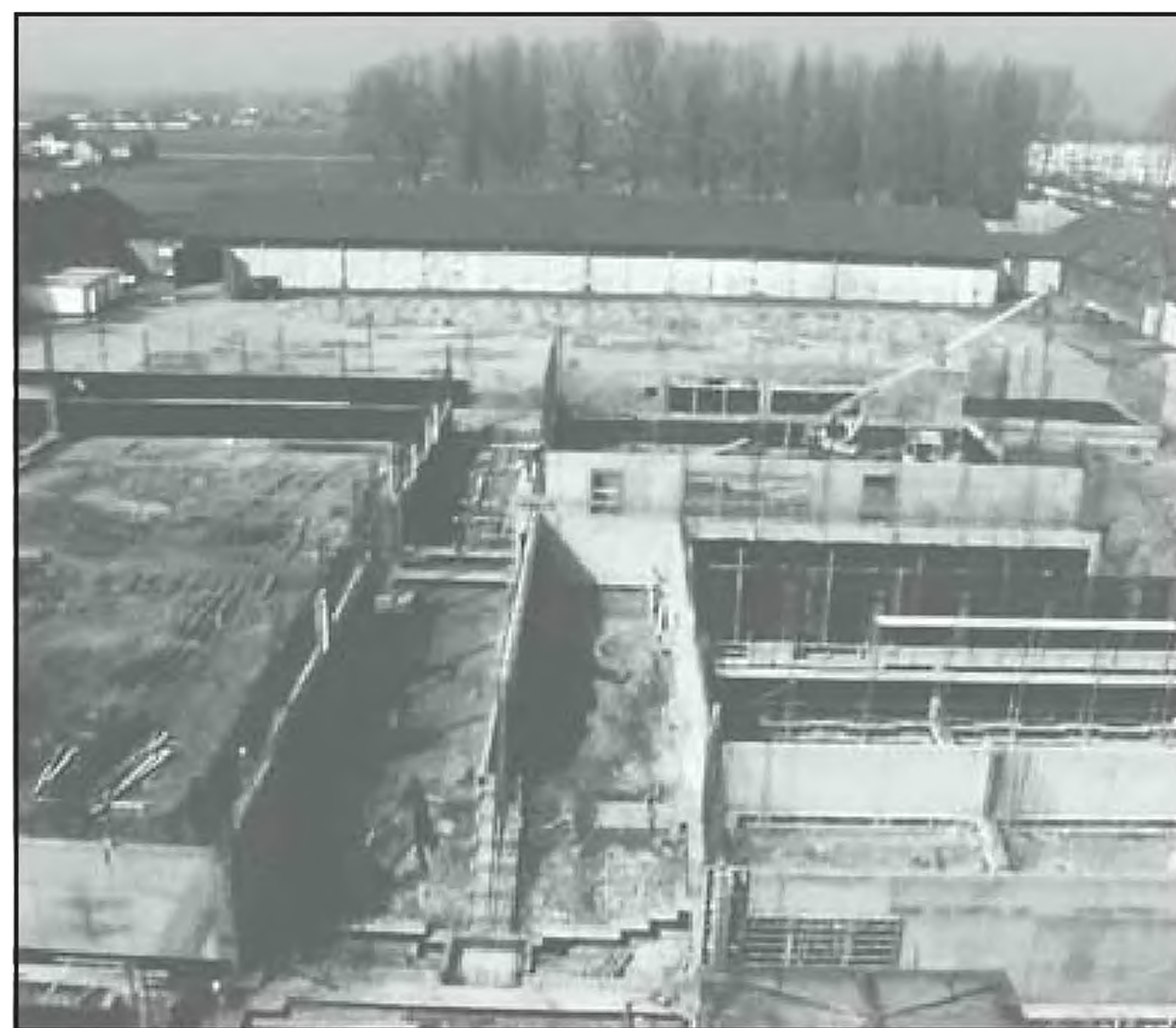
Na budowę II kampusu Politechnika Opolska otrzymała dofinansowanie w kwocie przeszło 13,5 mln złotych.
