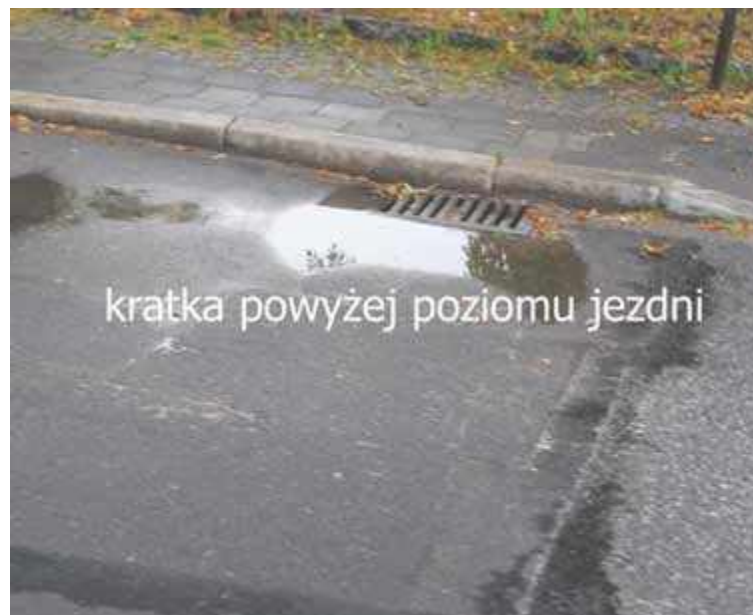
Kratki wody opadowej znajdują się powyżej poziomu jezdni, stąd kałuże
