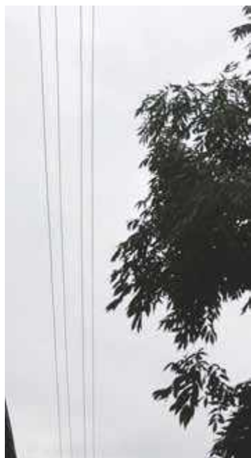
Podczas wiatru gałęzie drzewa rosnącego na skwerku ocierają o linię energetyczną
