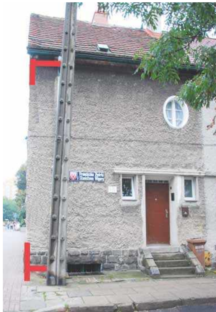
Słup oświetleniowy wskutek podmycia przechyla się w lewą stronę. Czekać tylko, kiedy się przewróci
