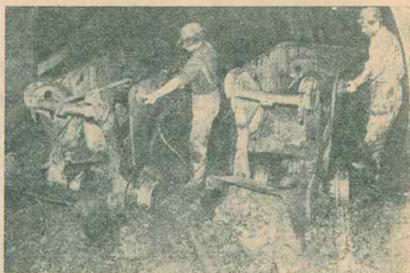
图 3-2 使用两台后卸式装岩机的岩巷
